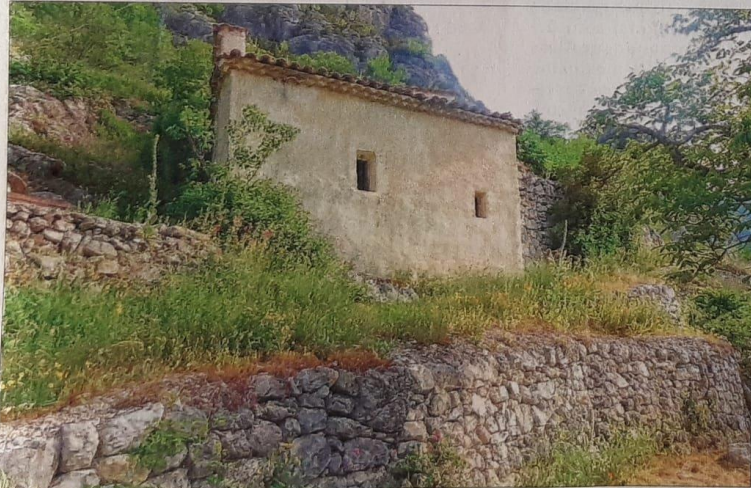
Le prochain chantier a pour but d'aménager un accès plus confortable à la chapelle Notre-Dame de Bon Secours. Photo Le DL
