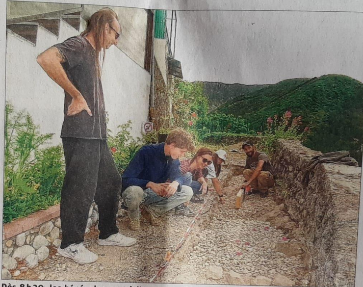
Dès 8 h 30, les bénévoles sont à l'œuvre sur le chantier. Photo Le DL/Pierre PINERO
